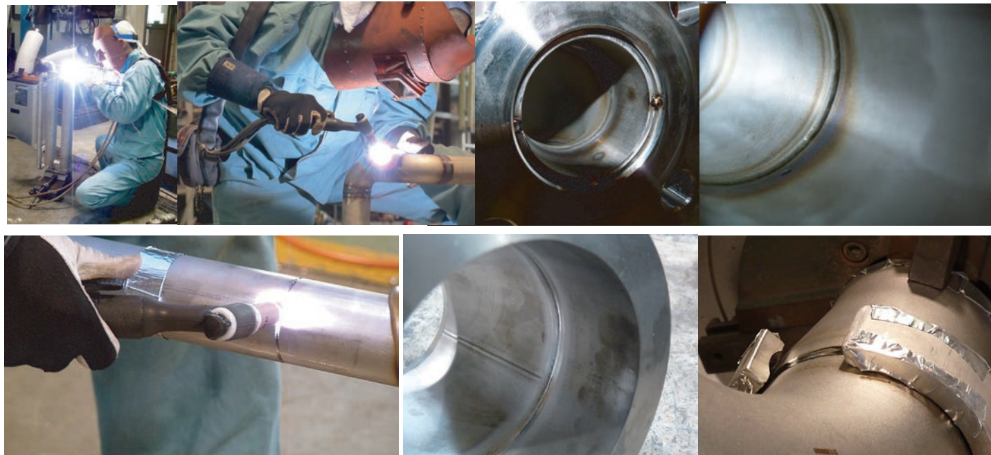
チタン溶接 （パイプ裏波溶接）
