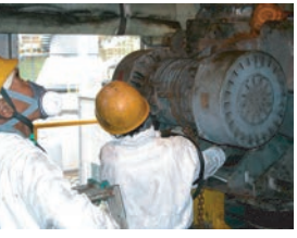
【ポンプ修理工事】
