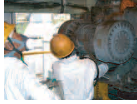
【ポンプ修理工事】
