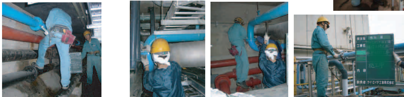
小口径の配管
